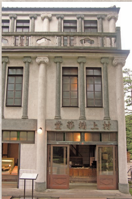
【写真-8 人造石洗い出し仕上げでつくられた村上精華堂のファサード（撮影：安野）】
