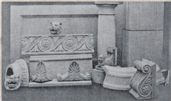
【写真-4 広島芸備銀行の外装工事で使われた型抜きによる岩元式ストーン・ブロック（出典：建築土木資料集覧刊行会編『建築土木資料集覧 昭和八年用』同発行 1933年）】
